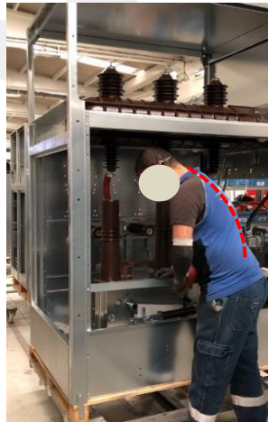
Şekil 58 Kesici ve ayırıcı bağlantı bakırların montajı sırasındaki vücut duruşu
