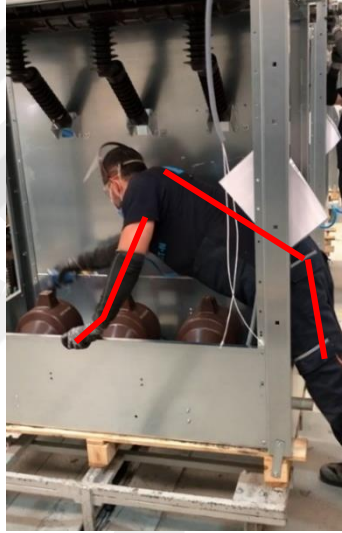
Şekil 34 Operatörün trafoların hücre içerisine montaj alt faaliyeti
