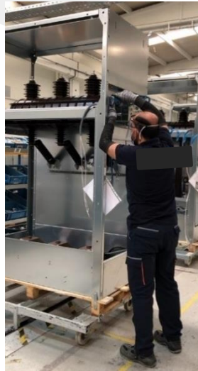
Şekil 38 Operatörün kablo düzenleme montaj alt faaliyet adımı
