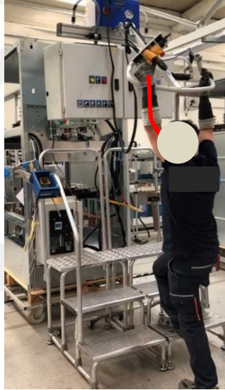
Şekil 50 Vakumlu vinç yardım ile panonun hücreye taşınması alt faaliyet adımı
