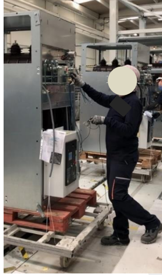
Şekil 43 Yük ayırıcı switch montaj işlemi alt faaliyet adımı
