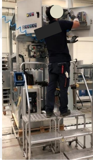
Şekil 51 Operatörün havalı tork sıkıcı ile pano montajı alt faaliyet adımı
