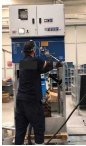
Şekil 70 Pano içi kablo bağlantıları alt faaliyet adımı
