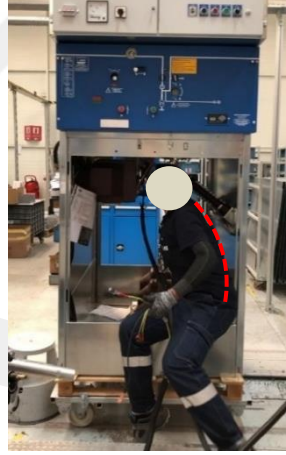
Şekil 71 Pano içi kablo bağlantıları alt faaliyet adımı
