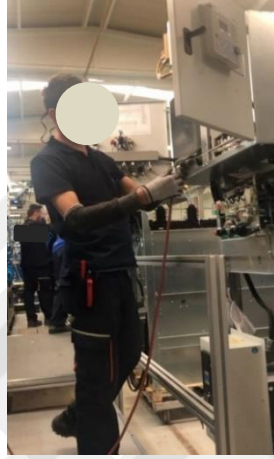
Şekil 63 Elektriksel test cihazı ile pano bağlantı alt faaliyet adımı
