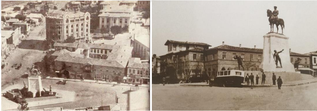
Resim 56: Yıkılan Taşhan Binası yukardan görünüş ve meydandan görünüş (Kaynak: http://mimdap.org/2018/09/tarih-ycinde-ankaranyn-kalbi-ulus/ )
