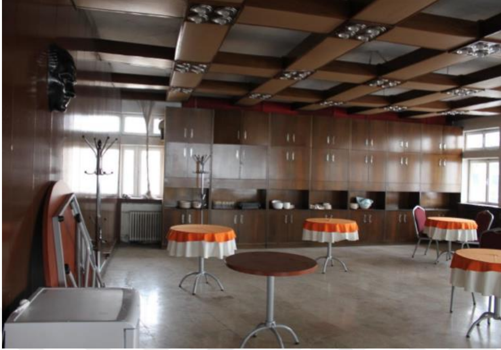
Resim 148: Restorasyon Öncesi, 5. kat (Asbü Yapı İşleri, 2017)
