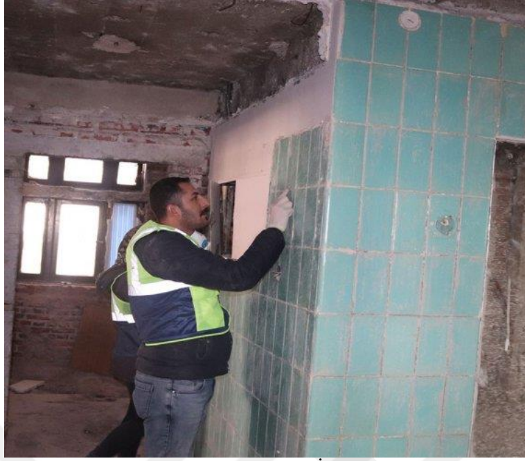
Resim 113: Restorasyon Aşaması Raspa İşlemi, 2. Kat (Şen, A. 2019)
