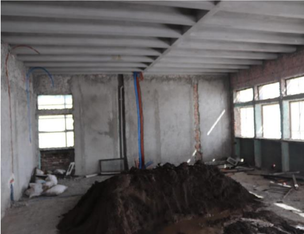
Resim 149: Restorasyon Aşaması, 5. kat (Şen, A. 2019)
