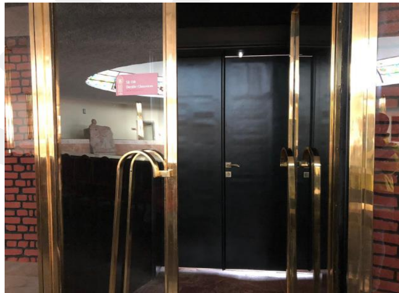
Resim 107: Restorasyon Öncesi ve Sonrası, 1. Kat (Şen, A. 2019)
