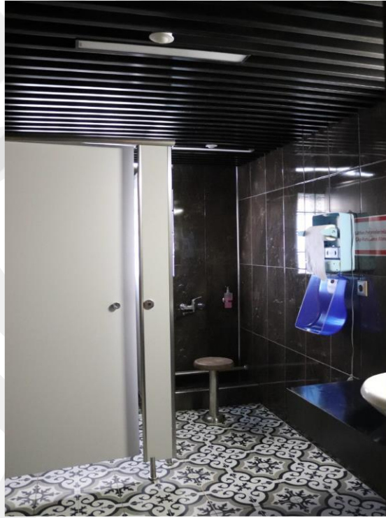
Resim 147: Restorasyon Öncesi ve Sonrası, 5. kat (Şen, A. 2019)
