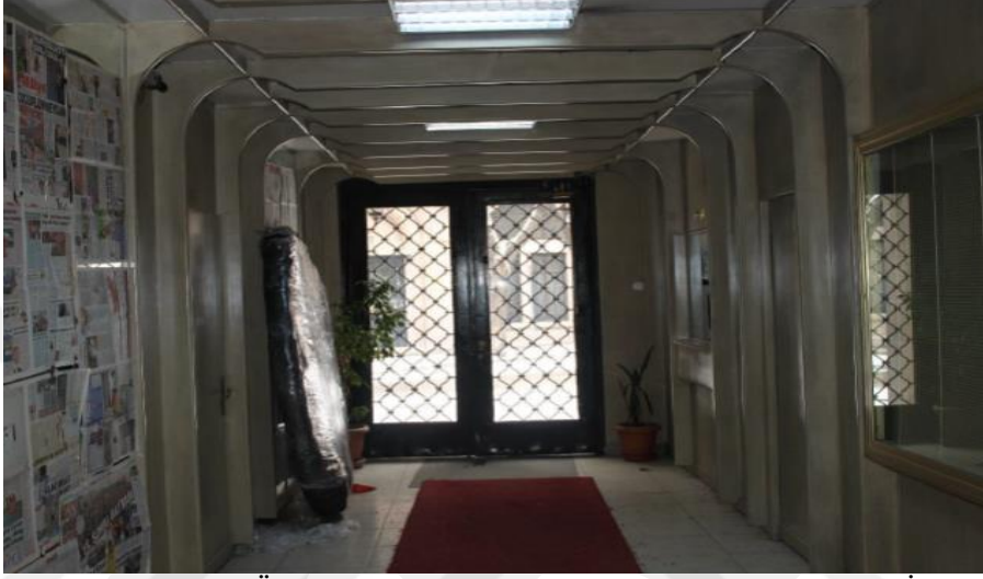
Resim 143: Restorasyon Öncesi, B Blok Zemin Kat Giriş Holü (Asbü Yapı İşleri, 2017)
