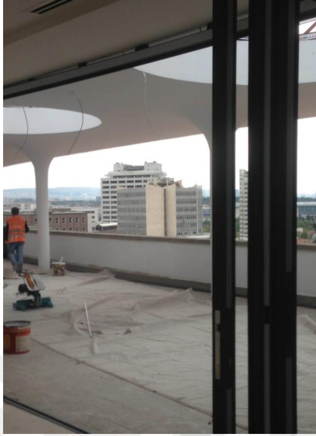
Resim 152: Restorasyon Aşaması, 5. kat (Şen, A. 2019)
