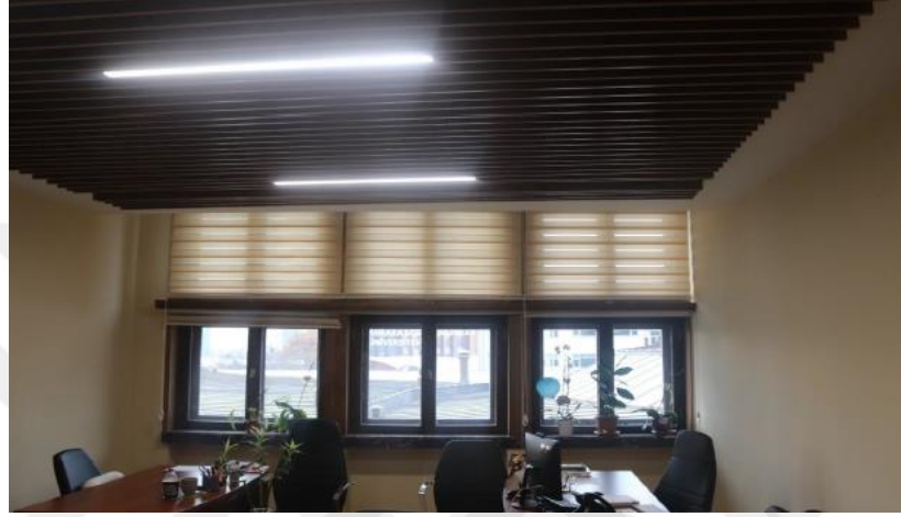
Resim 141: Restorasyon Öncesi ve Sonrası, 2. kat (Şen, A. 2019)
