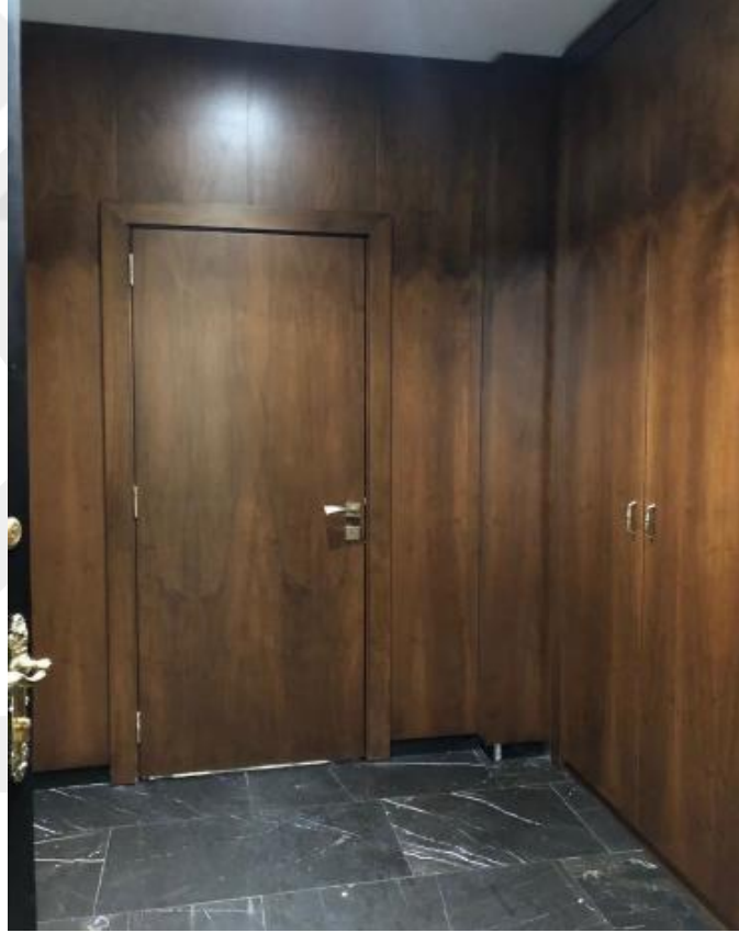
Resim 146: Restorasyon Öncesi ve Sonrası, 1. kat (Şen, A. 2019)
