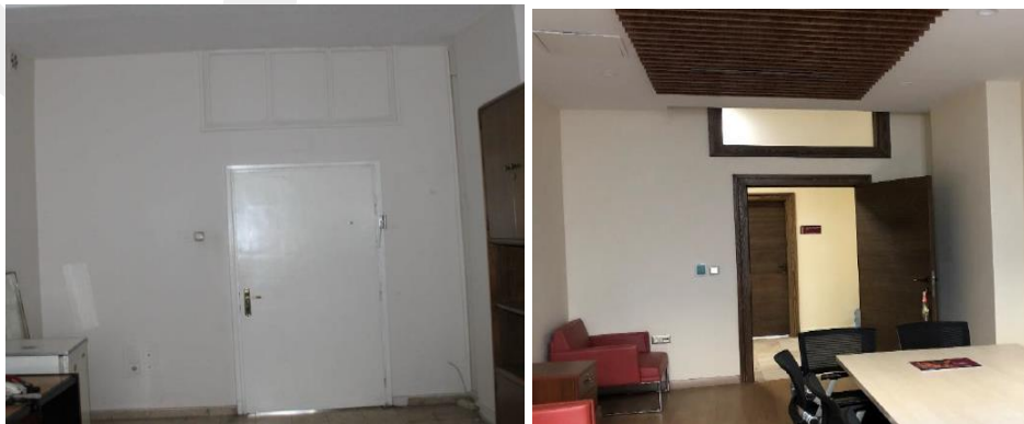
Resim 110: Restorasyon Öncesi ve Sonrası, 3. Kat (Şen, A. 2019)
