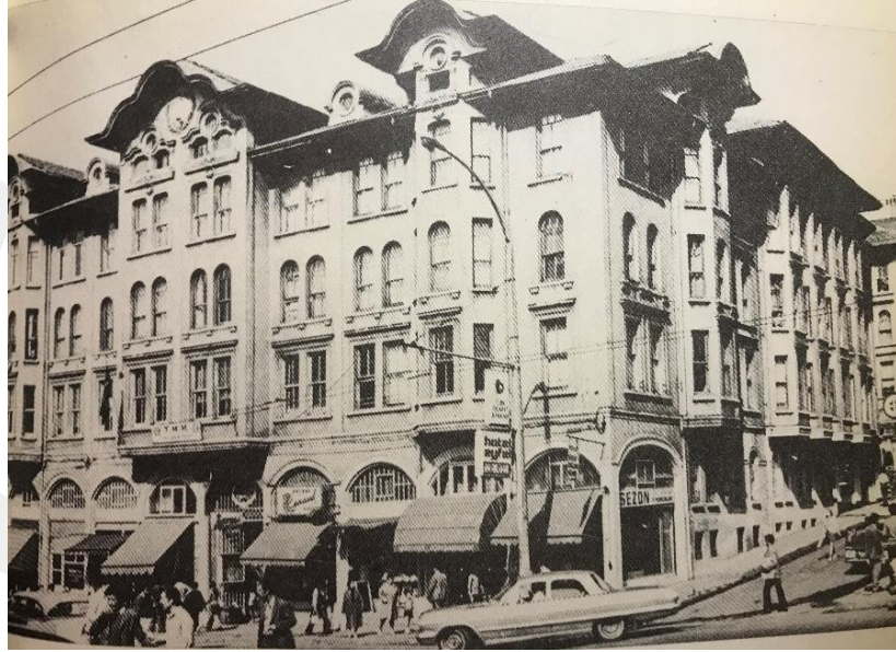
Resim 8: Mimar Kemalettin'in İstanbul Laleli'de yer alan Tayyare Apartmanları (Harikzadegan Apartmanları (Sözen, 1973 s.117)
