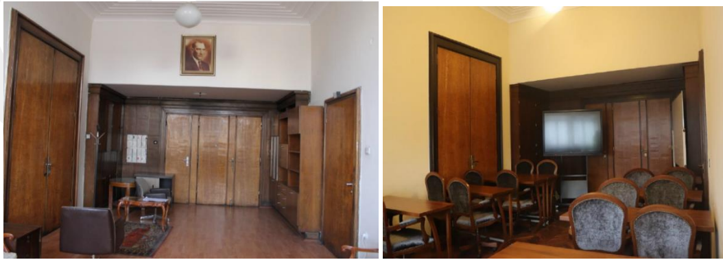
Resim 106: Restorasyon Öncesi ve Sonrası Korunan Mimari Elemanlar, 1. Kat (Şen, A. 2019)
