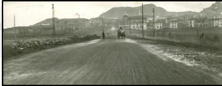
Şekil 4.19: Ankara İstasyon Meydanı'ndan İstasyon Caddesi'nin Kent Merkezine Bağlantısı 1900'ler.
