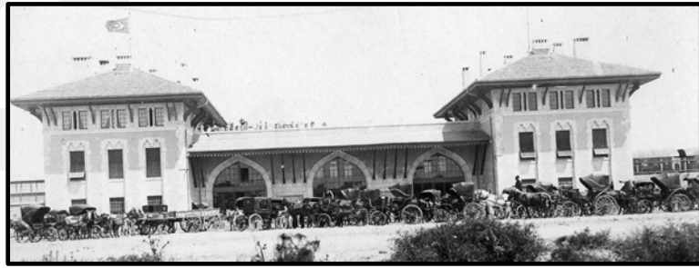
Şekil 3.26: Adana İstasyonu Meydan Cephesi. Kaynak: İnternet Kaynağı, Url 9.
