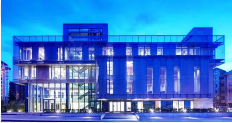
Şekil 4.1: Türkiye Mütcahhitler Birliği Binası Cephe Görsel (TMB 2022)
