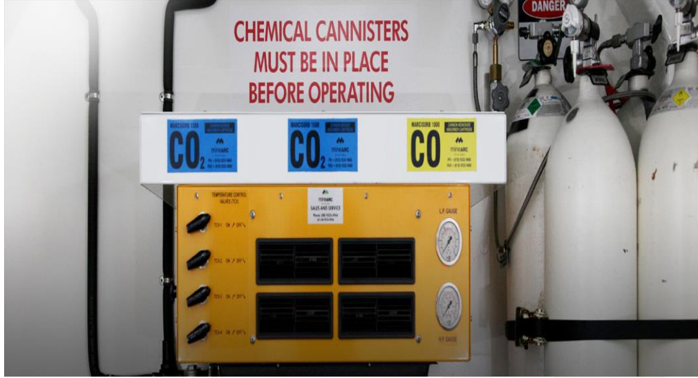
Şekil 22 Karbondioksit ve Karbonmonoksit tutucular 81
