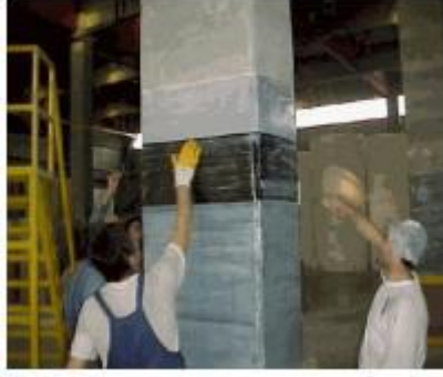
Resim 5. Elyaf takviyeli kolonların hazırlanması
