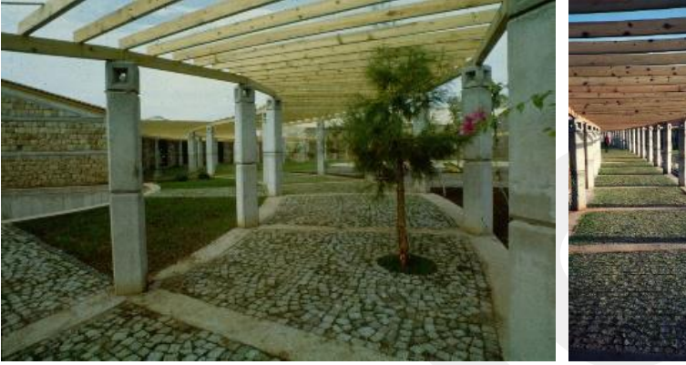
Şekil 3. Pergolalar ve Prefabrik Brüt Beton Kolonlar
