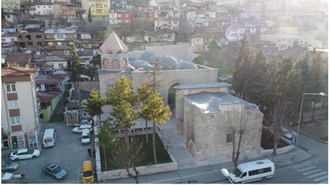
Şekil 19: Mehmet Paşa Caddesi'nden Gökmedrese Camii ve Torumtay Türbesi hava fotoğrafı. 11
