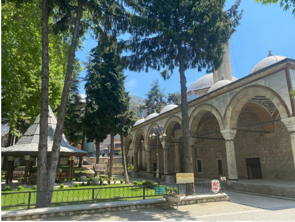
Şekil 28: 2022 yılı Mehmet Paşa Camii doğu cephesi görünümü. 20
