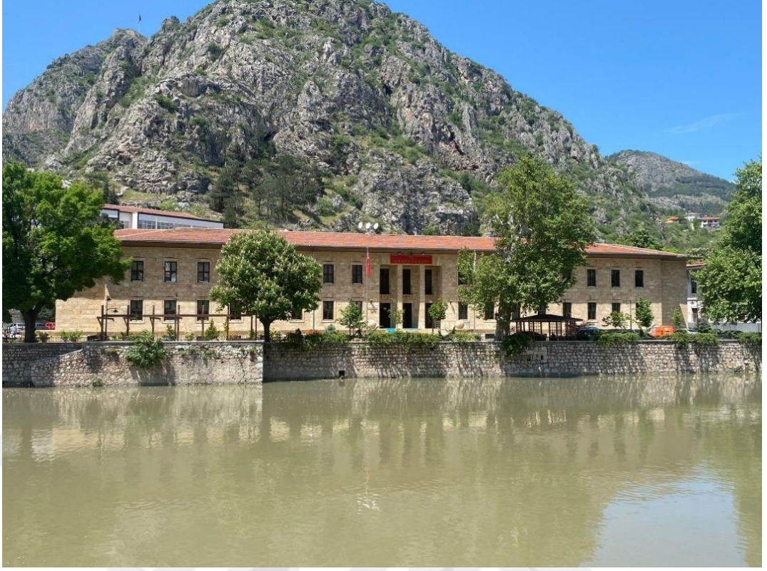
Şekil 45: Hükümet Konağı Mehmet Paşa Caddesi üzerinden görünümü. 35
