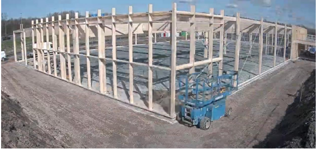
Şekil 3.6: Pencere ve Çatı Ahşap İmalatları (LIDL Supermarket 2021)
