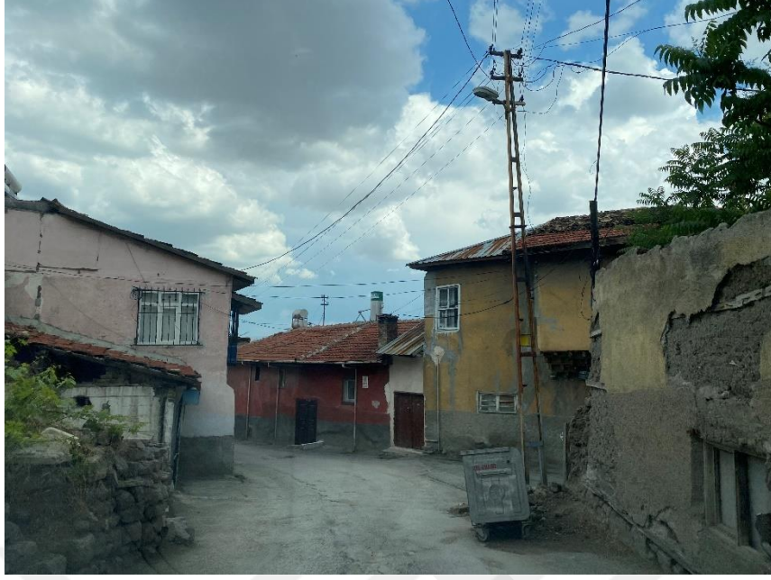
Şekil 137: Eryokuşu Sokağı Altyapı ve Yapısal Durum (Fotoğraf: Gür, C., 24/05/2022)
