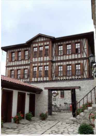
Şekil 15: Geleneksel Safranbolu Evleri ve ahşap yapı sistemi (Kahyaoğlu 2021).
