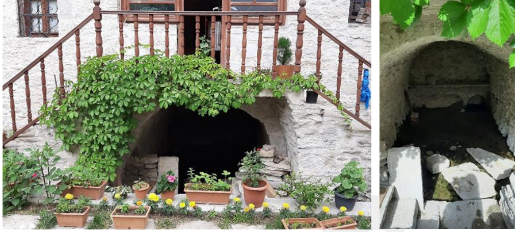
Şekil 18: Muhsin Bey Konağının bahçesinde bulunan sarnıç (Kahyaoğlu 2021).
