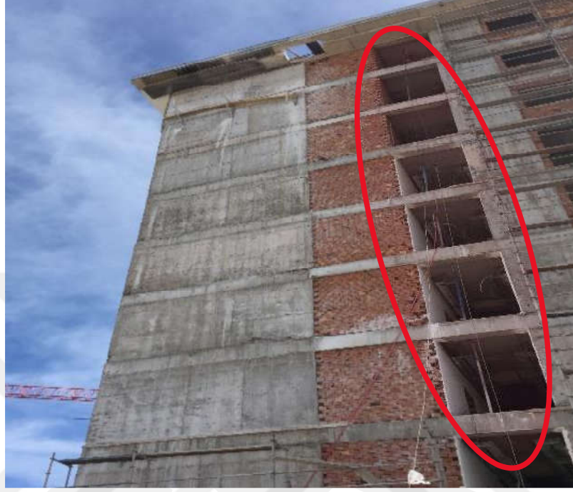
Şekil 2. 3: Yurt İnşaatı (Doğan, 2019)
