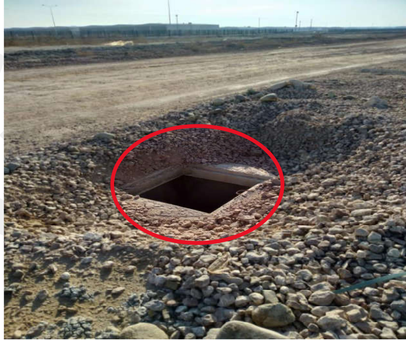
Şekil 2. 4: Yurt İnşaatı (Doğan, 2019)
