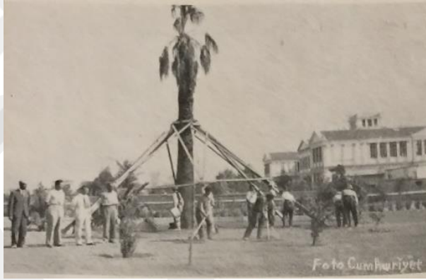
Resim 3.2. 130 İzmir Kültür Park yapım aşamasından bir fotoğraf (Belediyeler Dergisi, 1936, s. 40)
