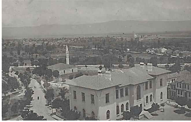
Resim 3.2. 107.Eskişehir Alaattin Cami'nin etrafı henüz park yapılmadan önceki hali (Web kaynak 4)
