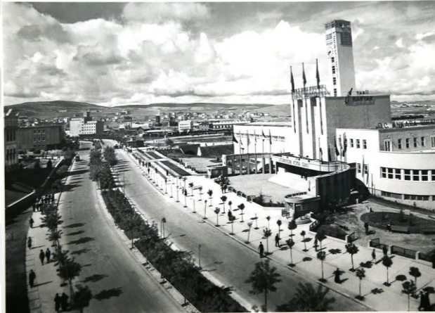
Resim 3.2. 49. Ankara Sergievi Binası, 1937 (Web kaynak 13)
