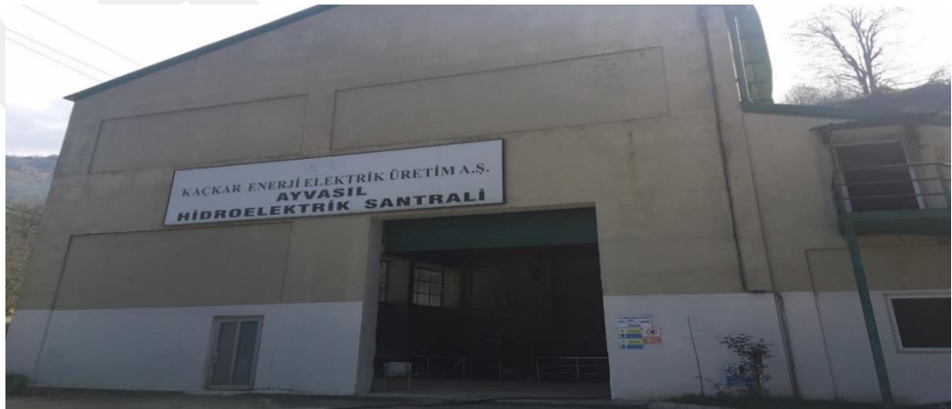
Şekil 11 Ayvasıl Hidroelektrik Santral Binası
