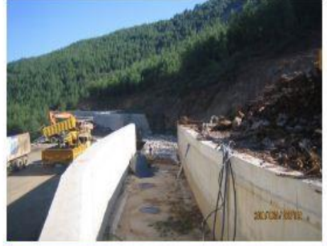
Toprak kayması neticesinde hasarlanmış iletim kanalı
