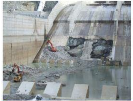
Oturma neticesinde dolusavakta meydana gelen hasar
