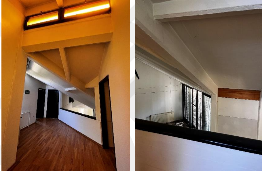
Şekil 4. 57: İsmailgil Evi, Birinci Kat, Zemin Kat Oturma Alanını Gören Ara Mekân (Akmil Kahraman 2022)
