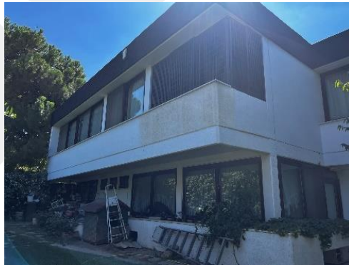
Şekil 4. 21: Esat Sivri Evi, Birinci Kat, Balkonun Dış Cephesine Uygulanan Ahşap Kafes Uygulaması (Akmil Kahraman 2022)
