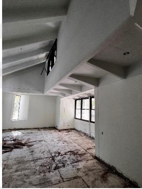
Şekil 4. 51: İsmailgil Evi, Zemin Kat Oturma Alanı, Cephede Çıkma ile Sedir Alanı (Akmil Kahraman 2022)
