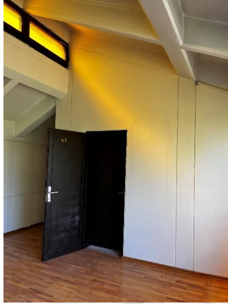
Şekil 4. 58: İsmailgil Evi, Birinci Kat, Yatak Odası ile Banyo Arasında Bulunan İki Adet Kapı (Akmil Kahraman 2022)
