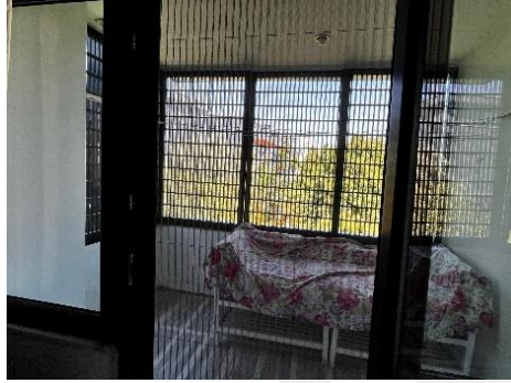
Şekil 4. 19: Esat Sivri Evi, Birinci Kat Ebeveyn Banyosu Çamaşır Balkonu, Balkonun Dış Cephesine Uygulanan Ahşap Kafes Uygulaması (Akmil Kahraman 2022)
