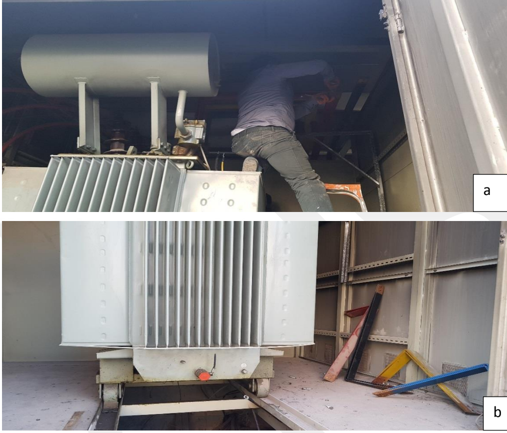
Fotoğraf 61:Trafo; a) Bağlantılarının Sökülmesi, b)İçi
