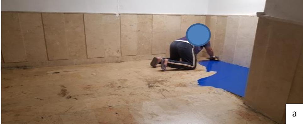
Fotoğraf 13: Hastane Zeminine Poliüretan (Epoksi) Uygulaması
