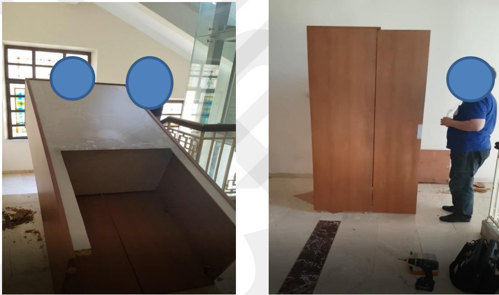
Fotoğraf 49: Çalışanların a) merdivende dolabı kaldırma işi, b) dolabı tamir işi
