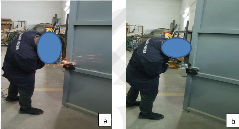
Fotoğraf 29: Spiral Aleti Yardımıyla Kilit Sökülme İşlemi(a,b))
