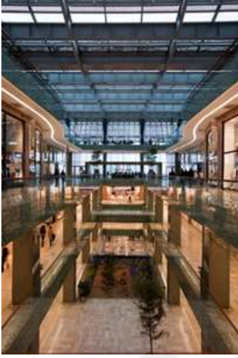
Şekil 5. 46: Kolonların Süreksizliği, Zemin Kattaki Boşluğun Kolonsuz Devam Ettiği Bölge
